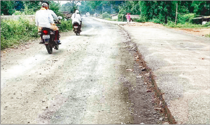
निर्माणाधीन आधी-अधूरी सड़क।
